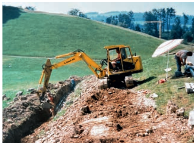
Grabarbeiten für Werkleitungen rechts der heutigen Driving Range
