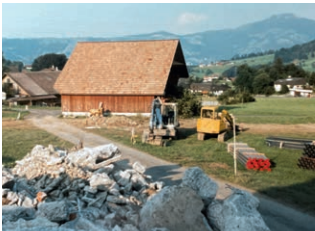
Die Werkleitungen sind eingelegt
