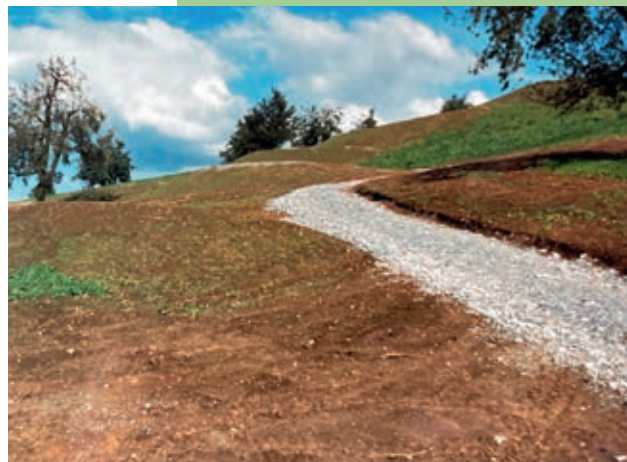
Der Weg ab dem Green 3 zur Talstrasse ist fertiggestellt
