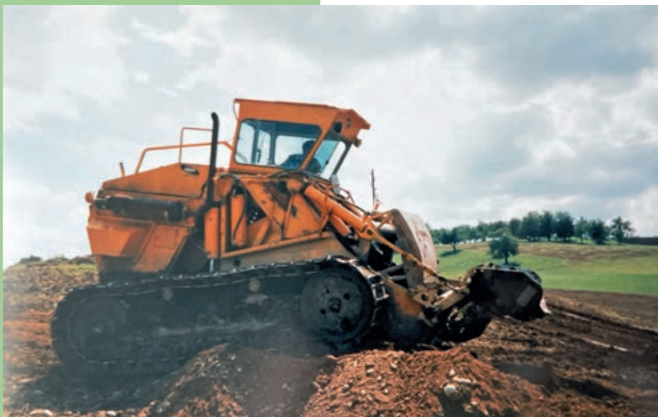
Die Drainagegräben sind aufgefäst und werden vor dem Verlegen der Rohre von Hand gereinigt
