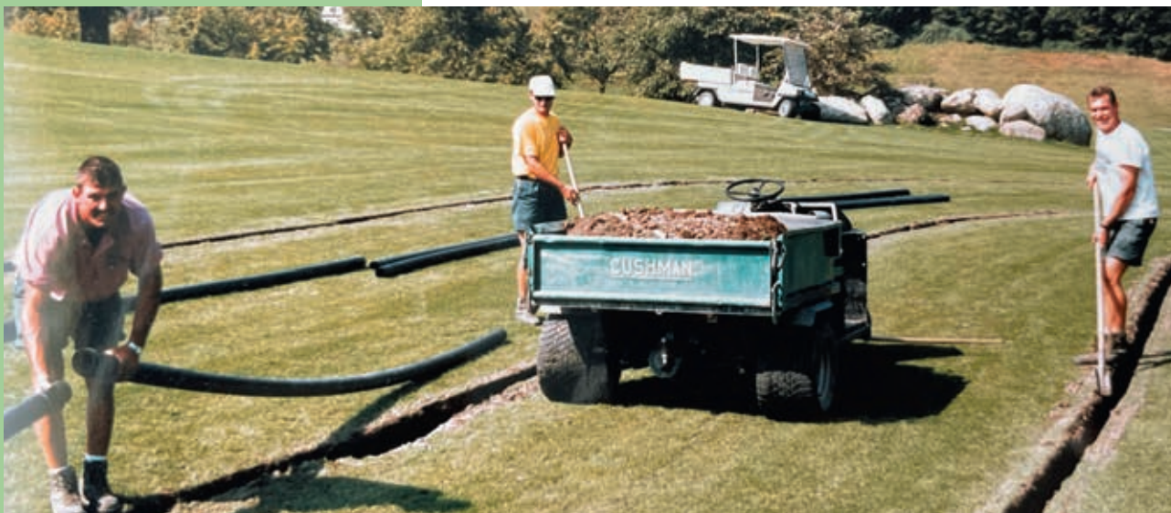
Die Drainagegräben sind aufgefäst und werden vor dem Verlegen der Rohre von Hand gereinigt
